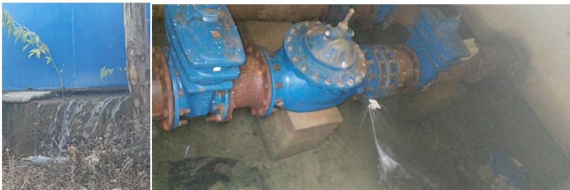
*Figura: Casos de fugas en el fondo de los depósitos (Tanque de Montecristi) y a nivel de las válvulas (Tanque de Navarrete)*
