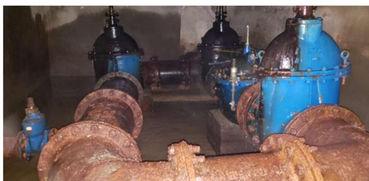
*Figura: Cajas de derivación hacia los tanque de Mao (Línea A)*
