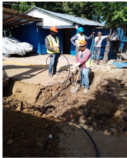
Colocación de acometidas potable
