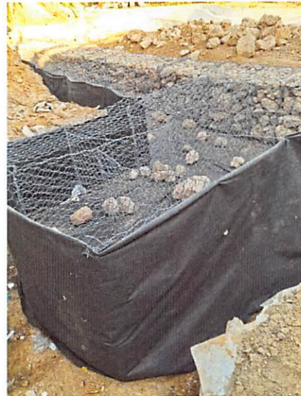
Construcción de muro de Gavión.
