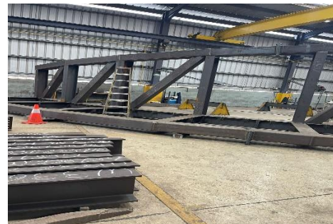
Fabricación de Estructura del Puente
