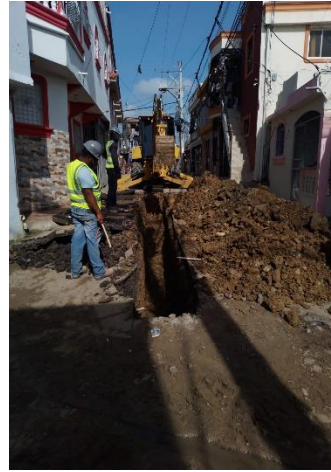
Excavación para tubería residual
