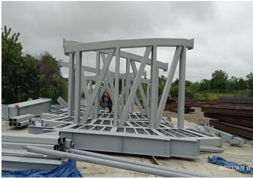
Fabricación de Estructura del Puente
