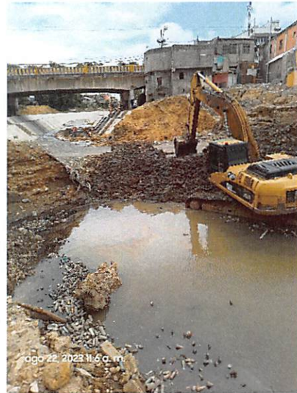
Conformación de ataguía.
