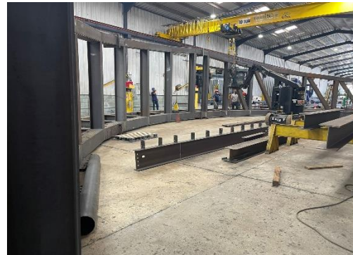
Fabricación de Estructura del Puente
