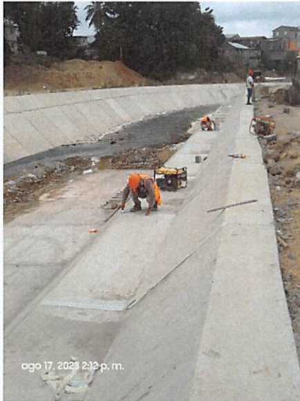
Cortes y masillado de Juntas de Construcción y de Expansión
