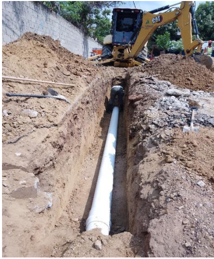
Colocación de tuberías de agua residual
