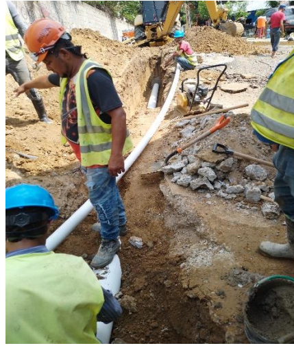
Colocación de tubería para agua potable
