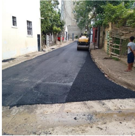
colocación de asfalto
