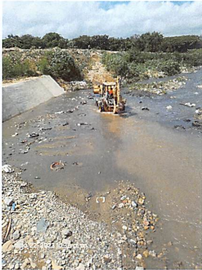
Limpieza de Canal.
