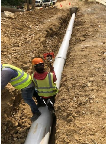
replanteo y control topográfico
