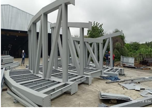
Fabricación de Estructura del Puente
