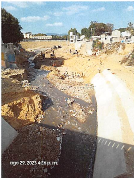
Colocación de Acero en E2+720
