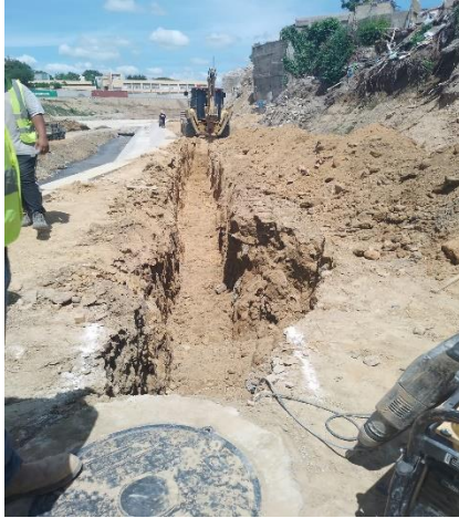
Excavación para Tubería
