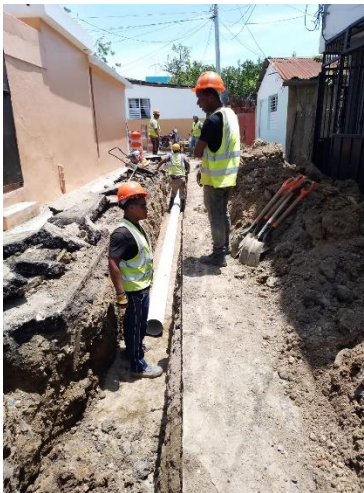
Colocación de tuberías de agua residual
