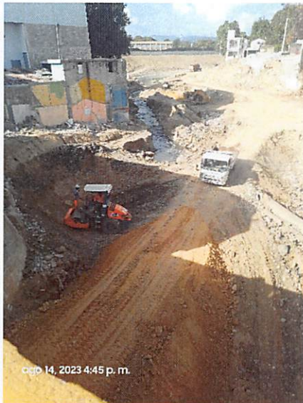
Relleno de Talud para Protección
