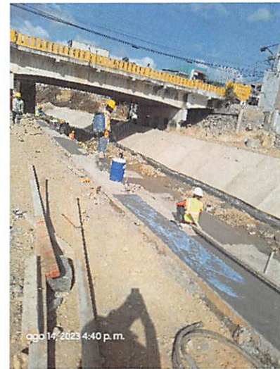
Hormigonado de Canal en E2+800.
