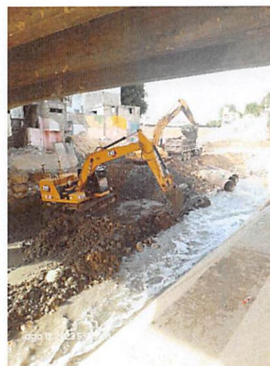
Excavación de Canal debajo del Puente Av. Imbert.
