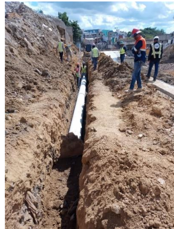
Colocación de Tubería
