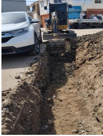
Excavación con equipo
