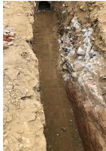
regularización de zanja
