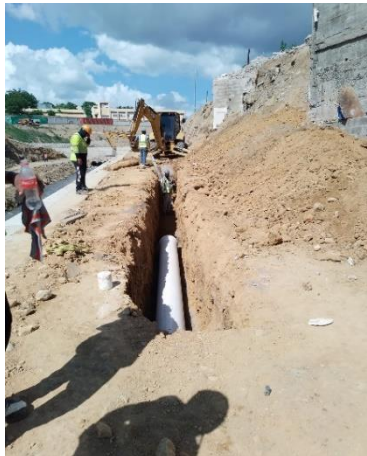
Instalación de Tubería de Agua Residual
