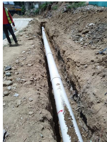
Colocación de tubería
