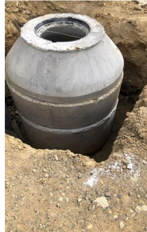
Excavación y colocación de registro
