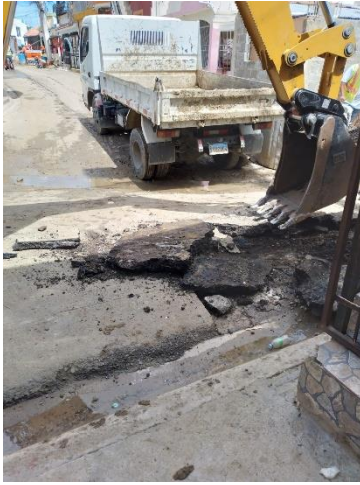
Remoción de carpeta asfáltica
