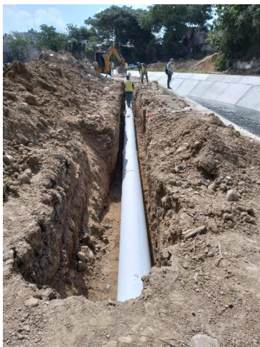
Instalación de tubería de agua residual
