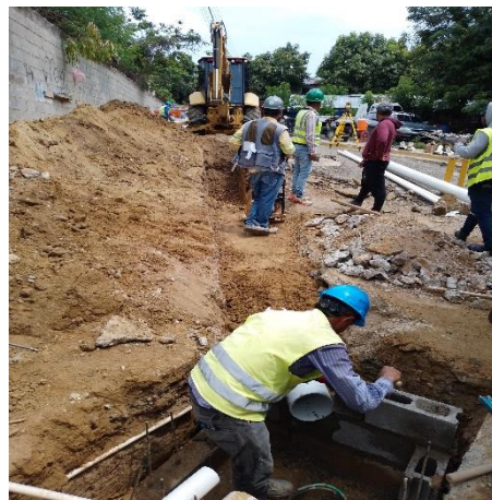
Compactación de material con equipo
