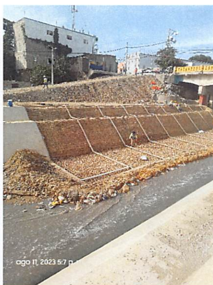
Colocación de Acero de 3/8 a 20cm en E2+800
