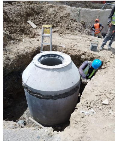
Excavación y Colocación de Registro
