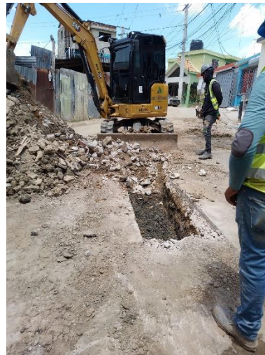
Excavación para acometida
