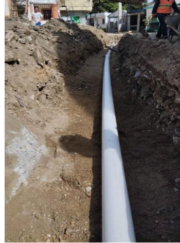
Instalación de tubería de agua potable
