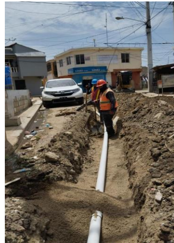
Colocación de tubería
