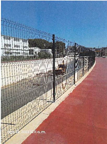
Limpieza de Canal
