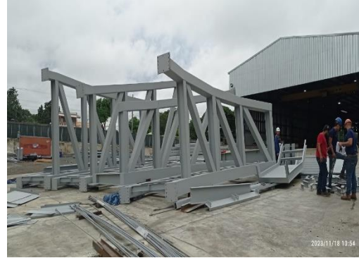
Fabricación de Estructura del Puente
