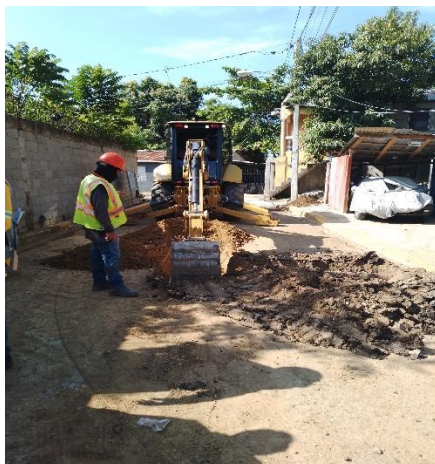
Excavación para colocación de tubería
