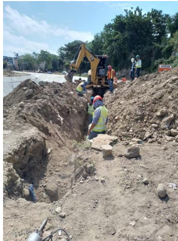
Excavación para tuberías de agua residual
