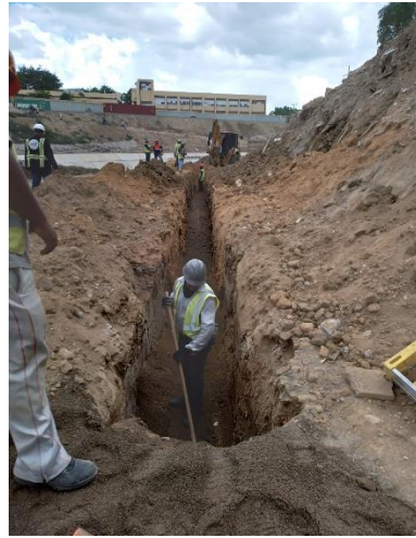
Regularización de Zanja
