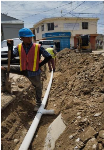
Instalación de tuberías de agua potable
