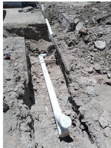
Colocación de acometida
