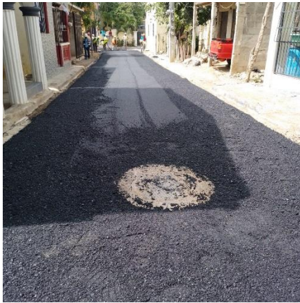
Colocación de asfalto
