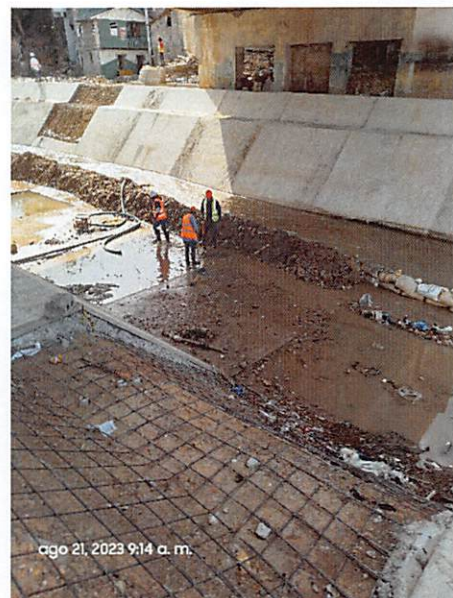
Limpieza de Paños por lluvias.
