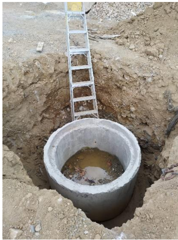
Colocación de registro
