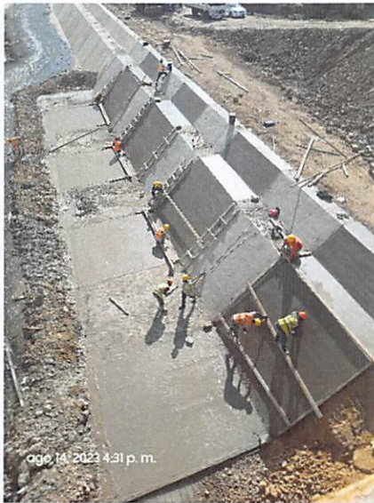
Hormigonado de Canal en E2+800.
