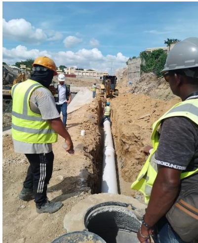
Colocación de Tubería
