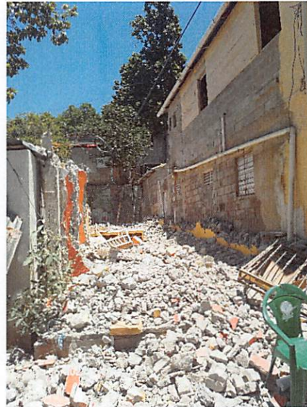
Demolición de estructuras. Luis Veras.
