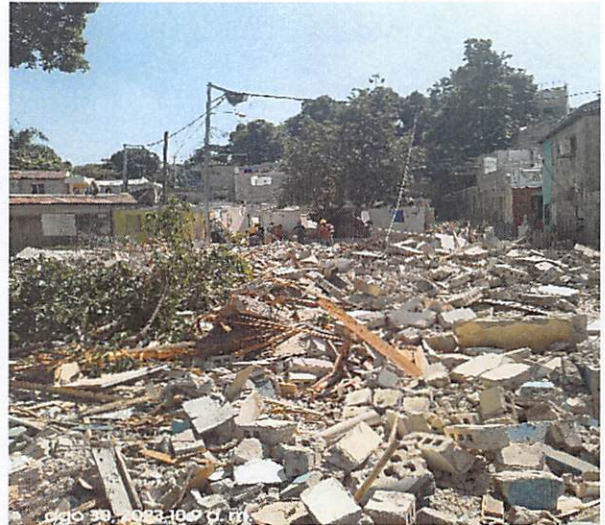
Demolición de estructuras.
