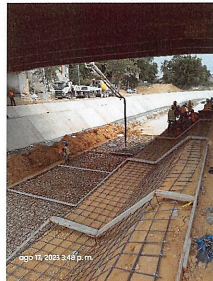
Hormigonado de Canal debajo del puente Av. Imbert.
