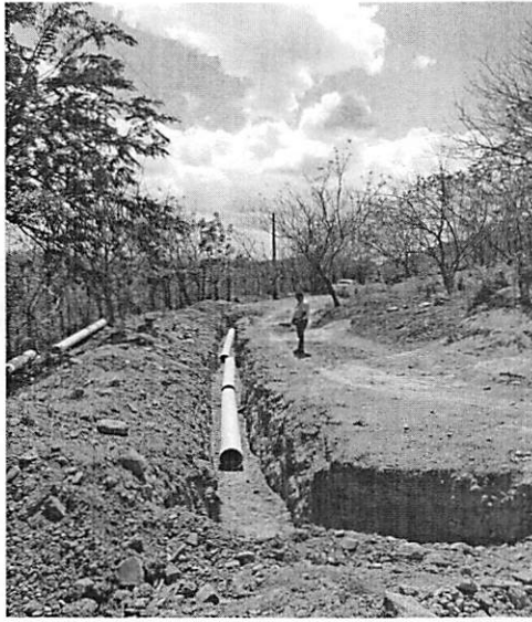
FOTO 1. Colocación Tubería Ø12" PVC SDR-26 1
