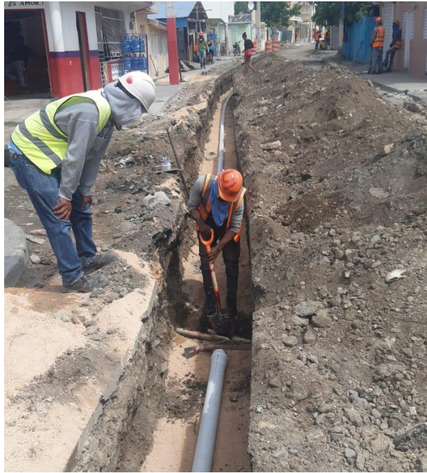
Ilustración 1: Colocación de Tubería PVC 3" SDR26
