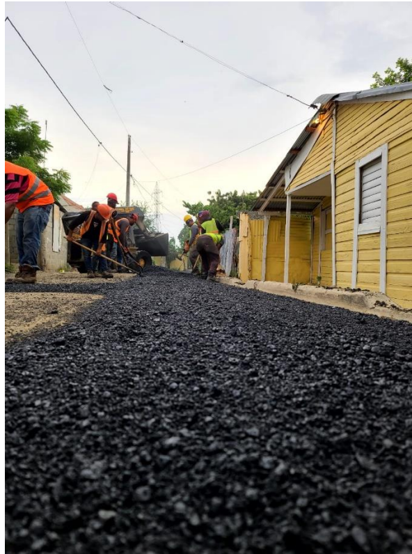
Ilustración 1: Colocación de Asfalto Zona Norte de Bani
