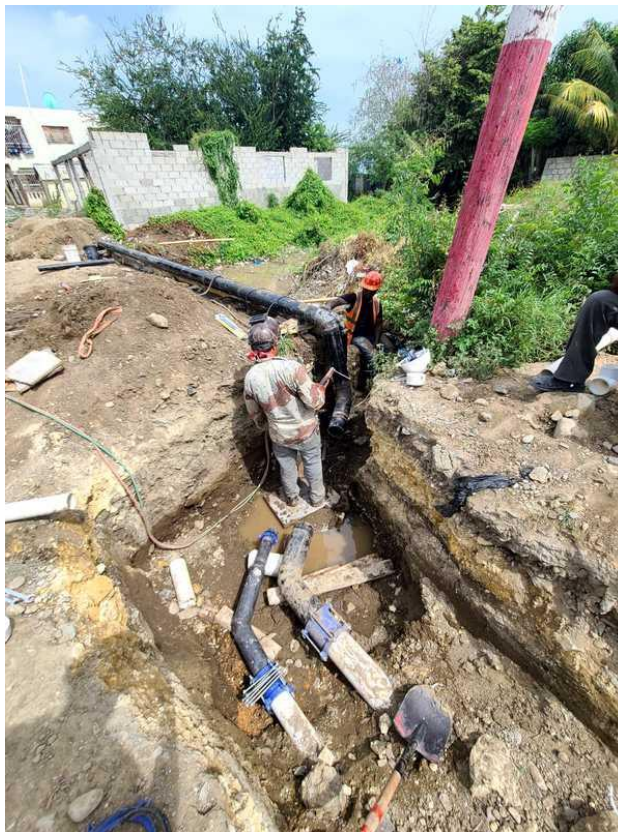
Ilustración 2: Preparación Cruce de Acero
