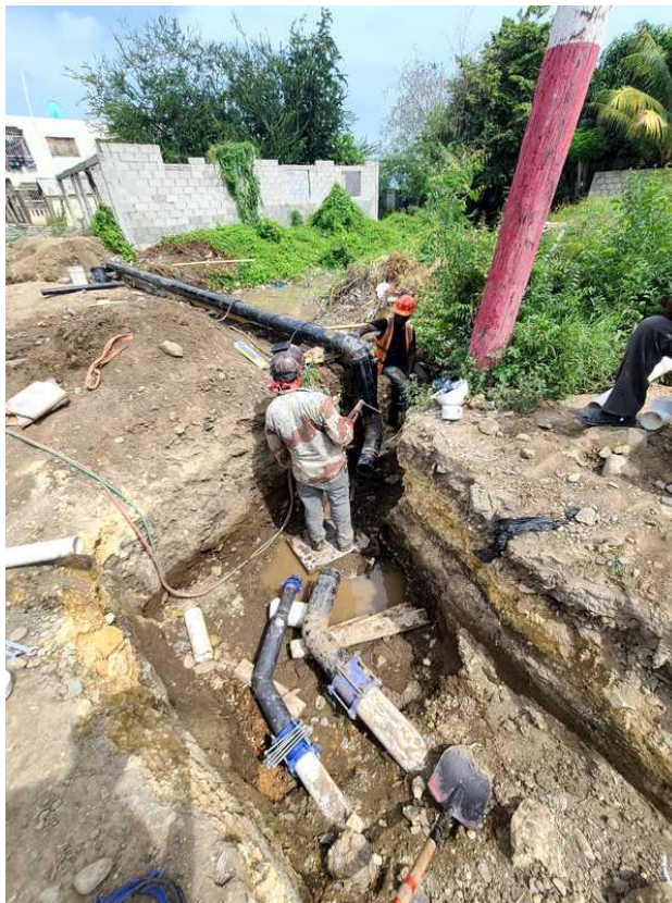
Ilustración 2: Preparación Cruce de Acero
