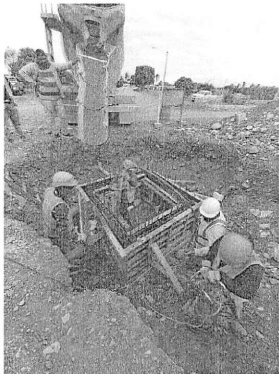
Ilustración 1: Construcción de Registros
