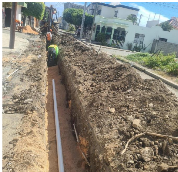
Ilustración 2: Colocación de Tubería PVC 4" SDR26
