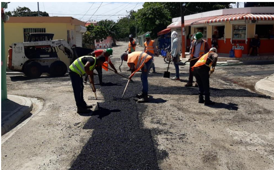
Ilustración 2: Colocación de Asfalto
