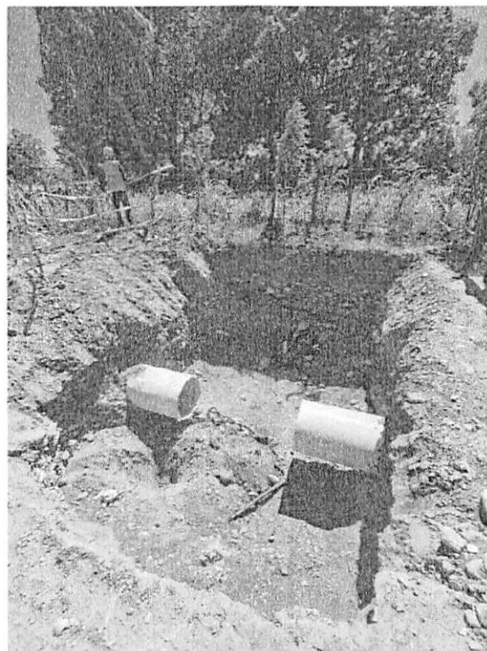
Ilustración 2: Tubería PVC 24\" SDR26
