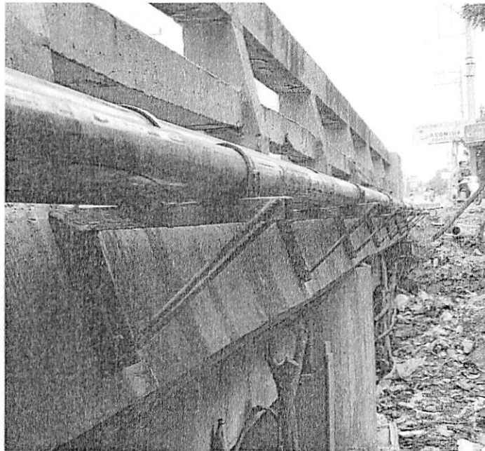
Ilustración 1: Cruce de Acero en Puente
