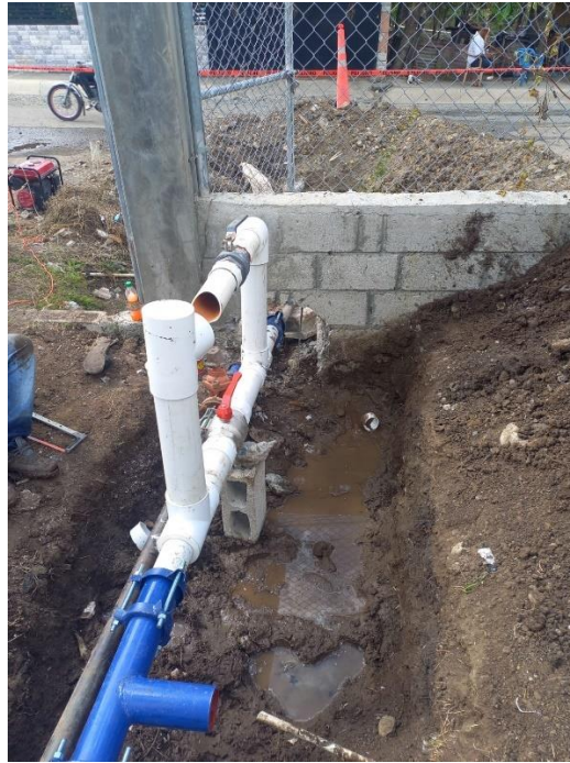
Ilustración 1: Preparación de Empalme a Depósito Regulador
