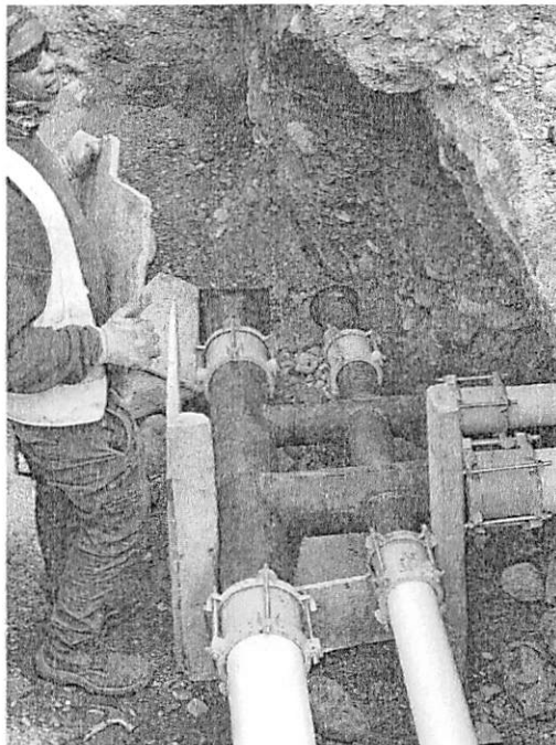
Ilustración 2: Colocación de Piezas Especiales
