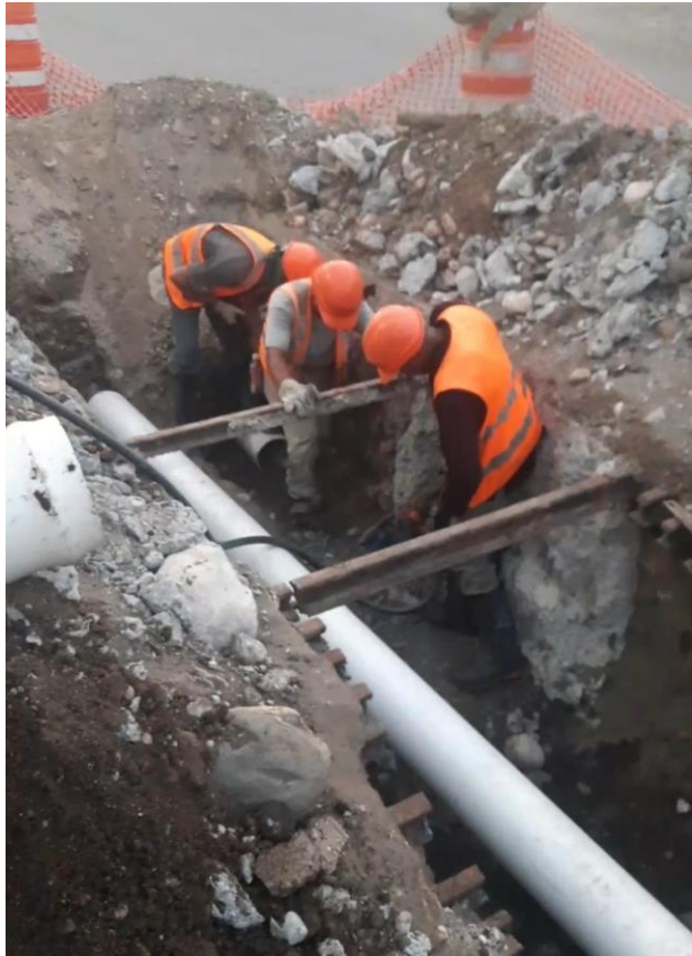
Ilustración 1: Colocación Tuberías 8" – Arroyo Hondo Quija Quieta
