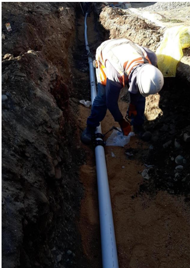
Ilustración 2: Colocación de Tubería PVC 4"SDR26
