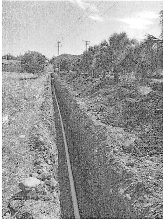
Ilustración 1: Colocación de Tubería PVC 3" SDR26
