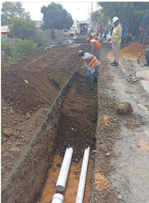
Ilustración 2: Colocación de Tubería PVC 4" SDR26
