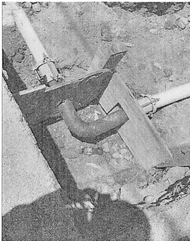
Ilustración 2: Preparación de Anclajes
