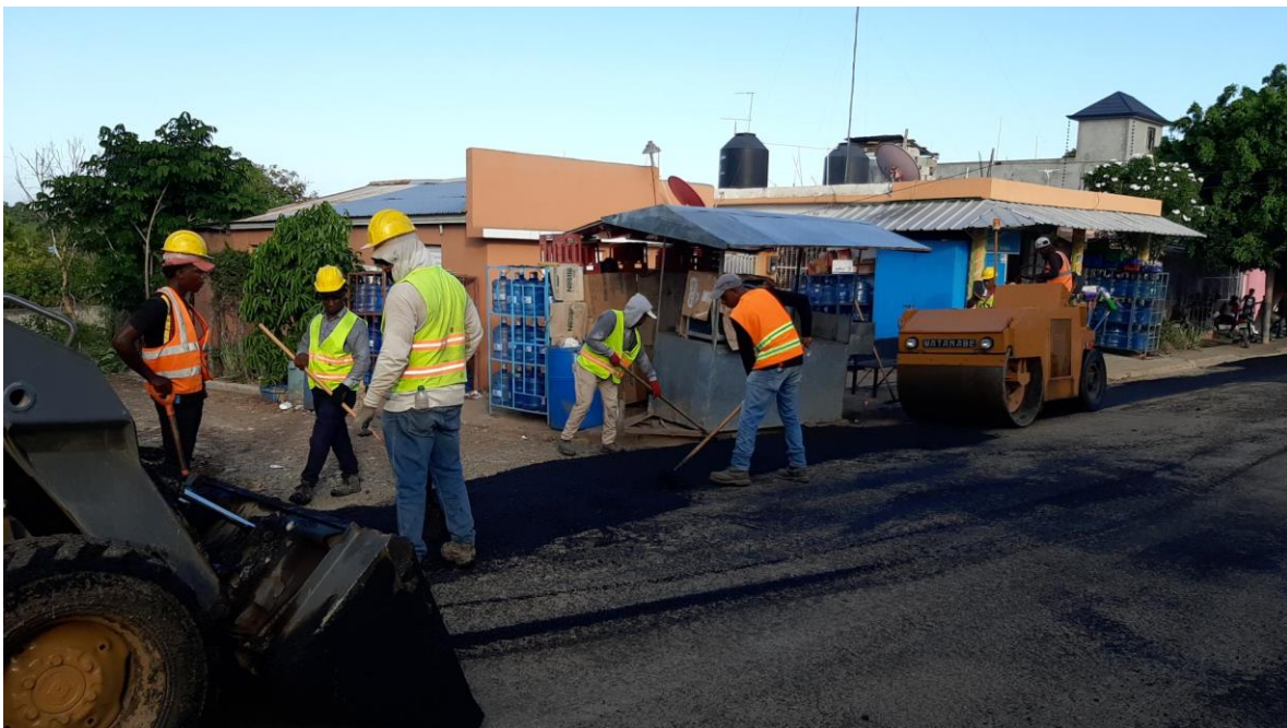
Ilustración 2: Colocación de Asfalto
