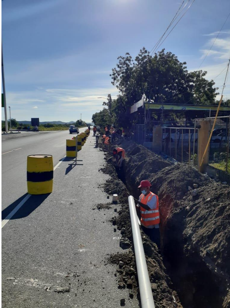
Ilustración 1: Colocación Tuberías 4"– Galeón
