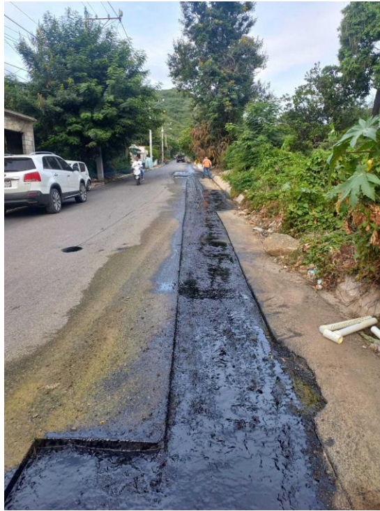
Ilustración 1: Riego de Adherencia
