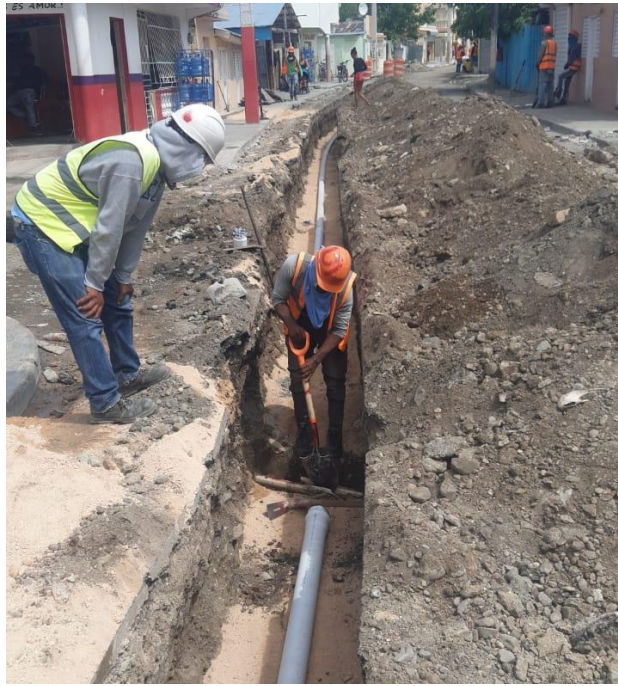
Ilustración 1: Colocación de Tubería PVC 3" SDR26
