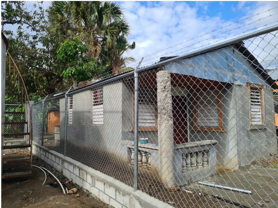
Ilustración 2: Terminación de Verja
