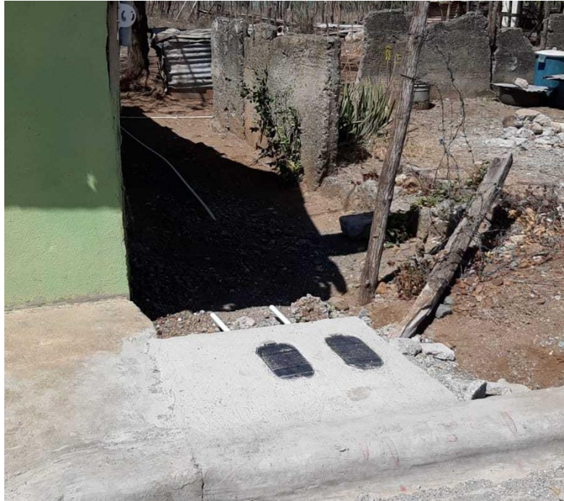
Ilustración 1: Colocación de Acometidas
