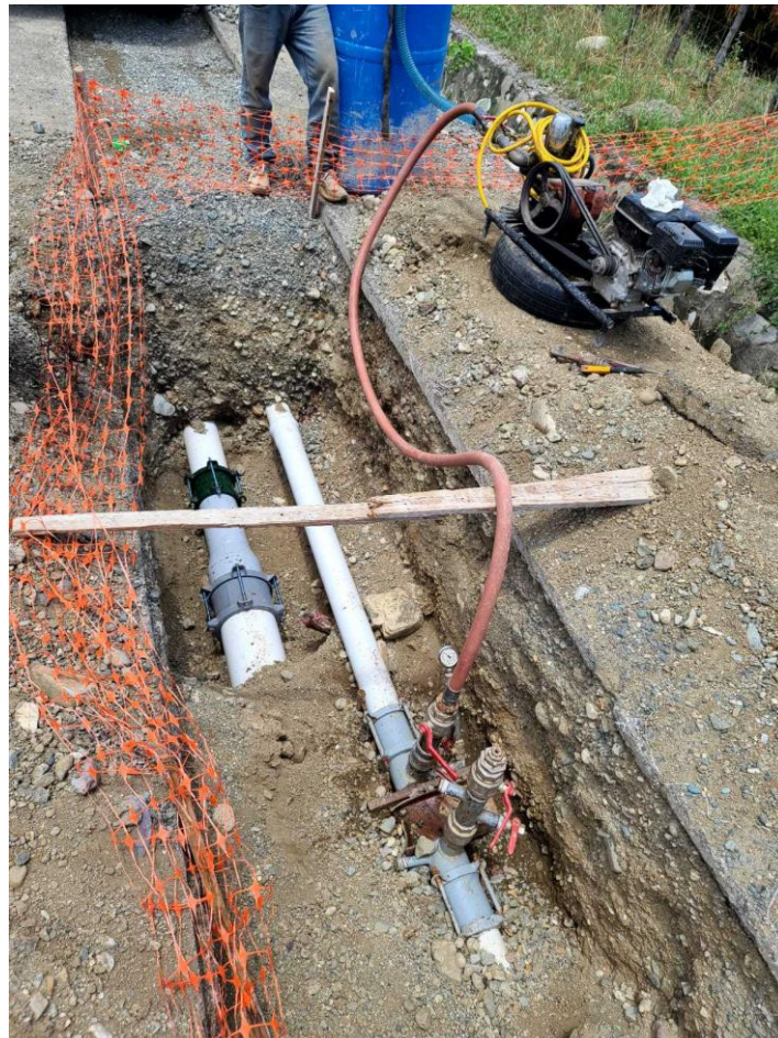
Ilustración 2: Prueba Hidrostática Redes Las Tablas
