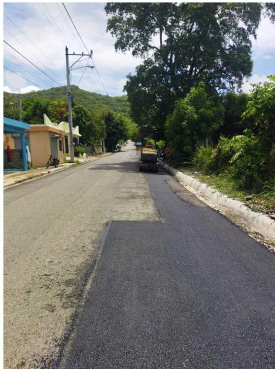
Ilustración 2: Colocación de Asfalto
