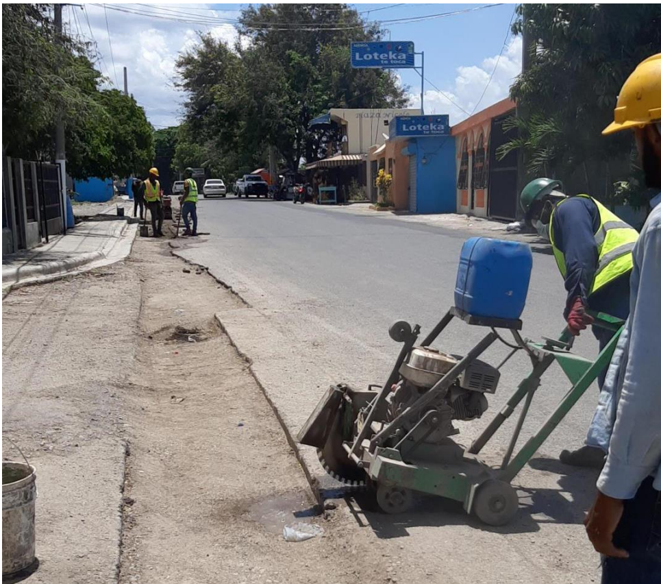
Ilustración 2: Corte de Asfalto
