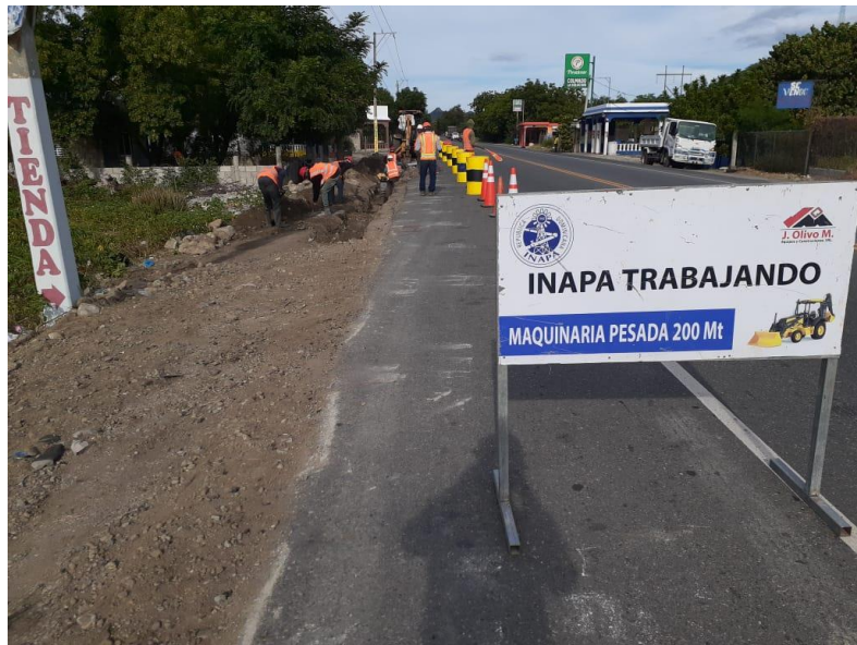
Ilustración 2: Colocación Tuberías 4"– Galeón
