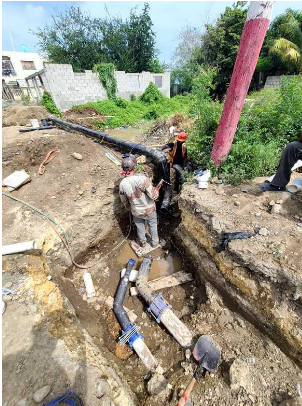
Ilustración 1: Colocación de Tubería PVC 3" SDR26
