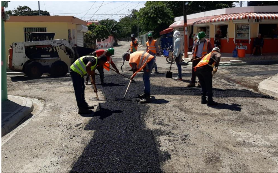
Ilustración 1: Colocación de Asfalto
