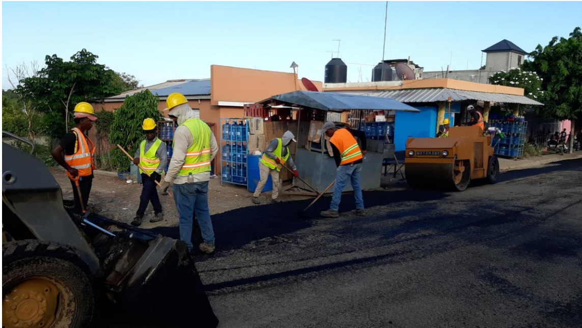
Ilustración 1: Colocación de Asfalto
