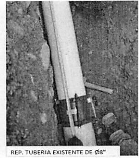
REP. TUBERIA EXISTENTE DE Ø8"
