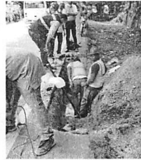
AVERIA TUBERIA EXISTENTE DE Ø8"
