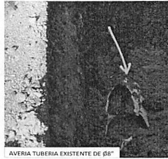
AVERIA TUBERIA EXISTENTE DE Ø8"
