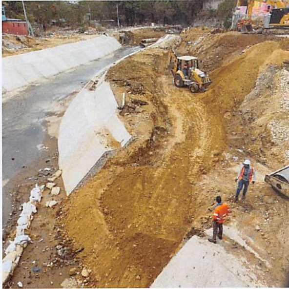
Relleno de Zanja de desvío en E2+890 a E3+000
