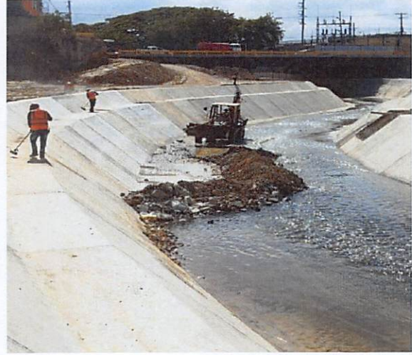
Limpieza y removiada de ataguía.
