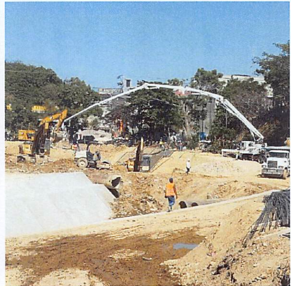
Hormigonado de Canal desde E2+800 a E2+890
