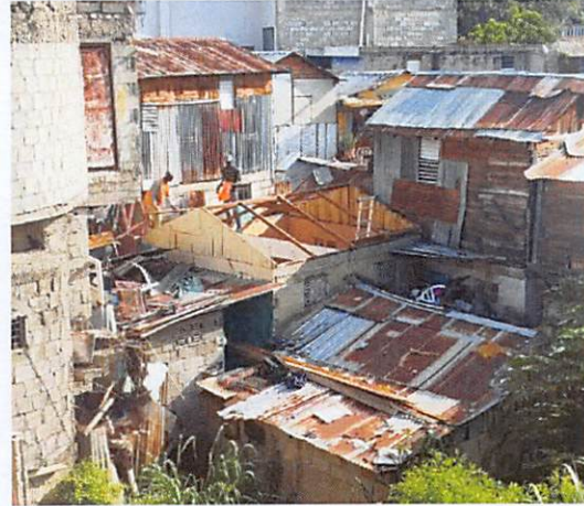
Demoliciones de Estructuras.
