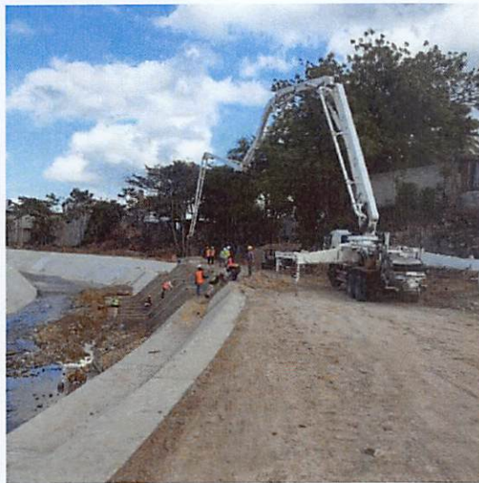
Hormigonado de Canal
