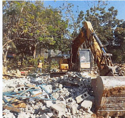
Demolición de Estructuras
