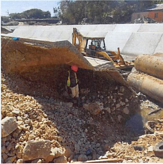
Reparación con piedra de encache en lateral izquierdo
