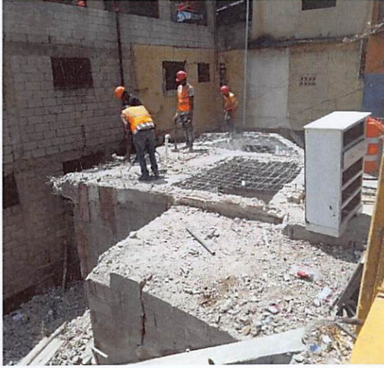
Demolición de Estructuras
