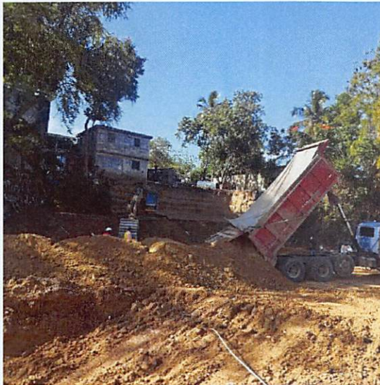
Relleno de Talud para Protección
