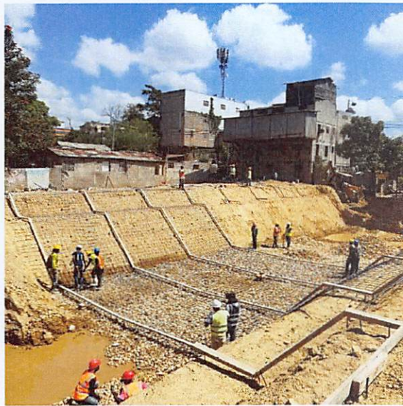
Colocación de Acero de E2+800 a E2+890
