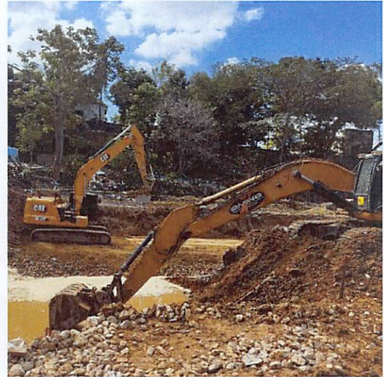
Excavación de Canal desde E2+800 a E2+890
