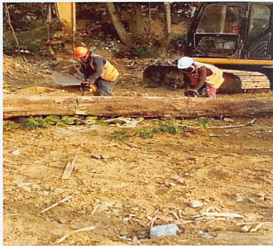
Desbroce y corte de arboles
