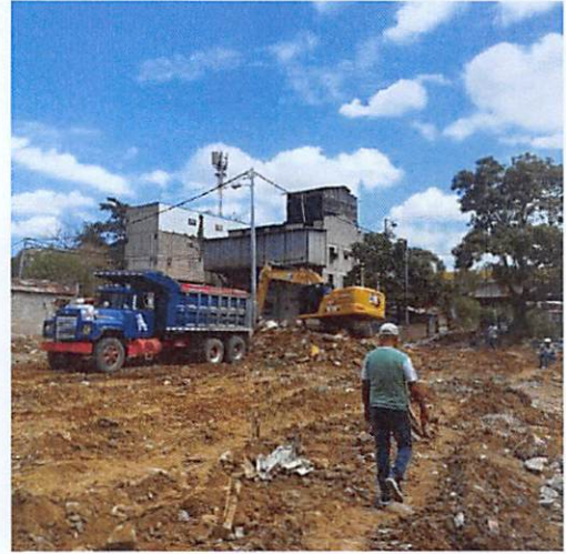
Bote de Escombros de Demoliciones
