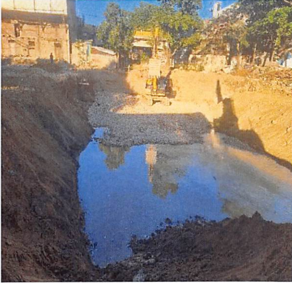
Colocación de Granzote desde E2+800 a E2+890
