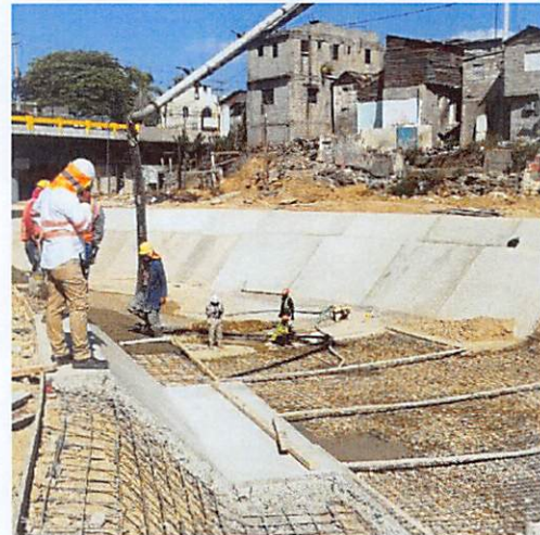
Hormigonado de Canal, Fondo y Ambos laterales E2+950.
