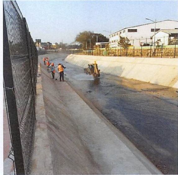
Limpieza de Canal
