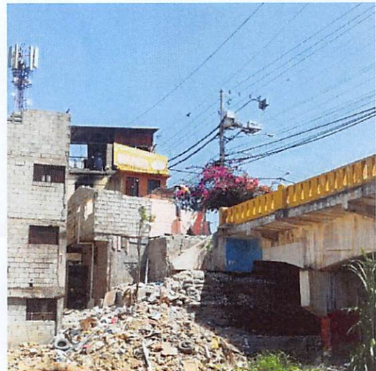
Demolición de Estructuras
