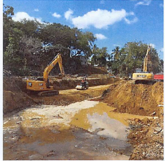
Colocación de Relleno desde E2+800 a E2+890
